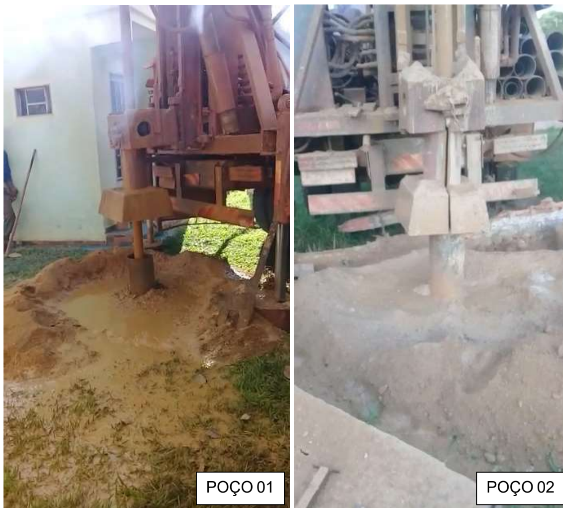
Figura 1 - Perfuração Poço 01 e Poços 02.
