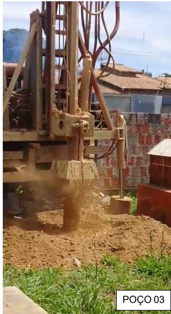
Figura 2 - Perfuração Poço 03.
