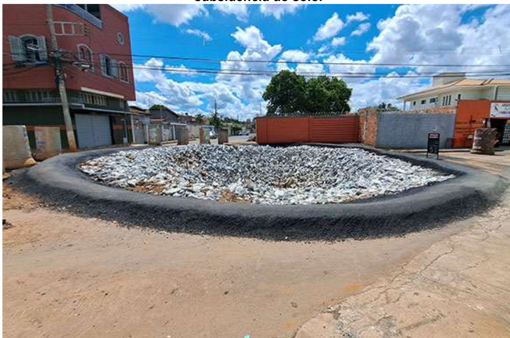
Figura 17 - Buraco no bairro Santa Luzia, em Sete Lagoas, Minas Gerais, evidenciando a subsidência do solo.
